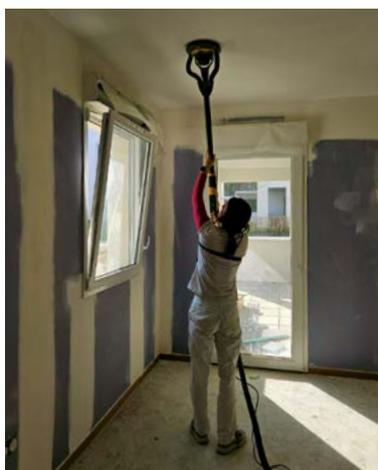
▲ Chantier 2 – Ponçage au plafond avec exosquelette de soutien cervical dynamique
