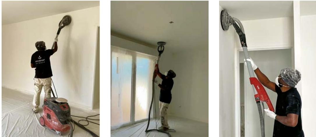
▲ Chantier 2 – Ponçage mur et plafond sans exosquelette (ponceuse b)
