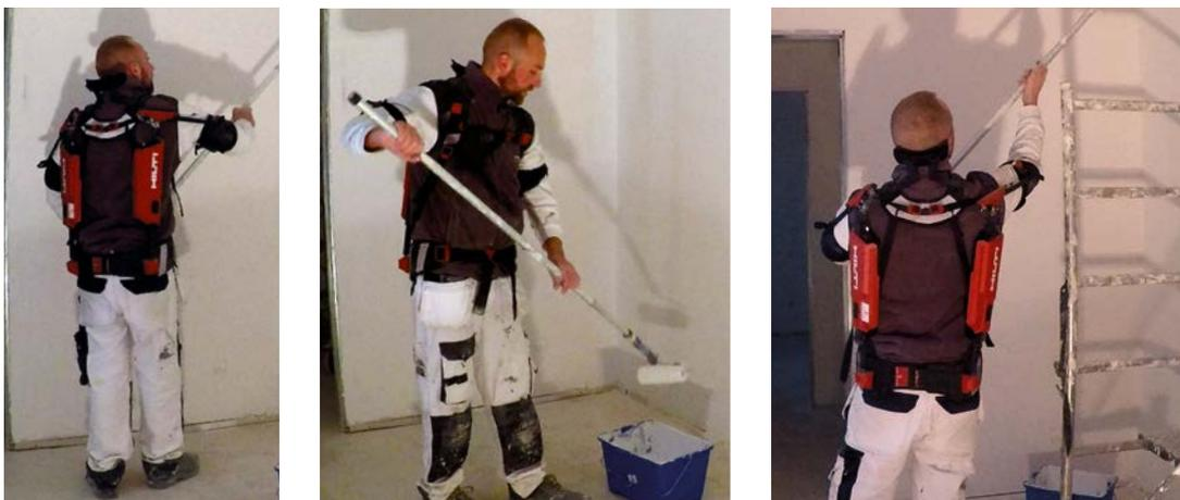
▲ Chantier 1 – Application de peinture au rouleau + perche, en plafond et mur, avec exosquelette d'assistance «bras en hauteur» et soutien cervical
