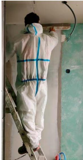
▲ Chantier 1 – Enduit manuel en mur, avec exosquelette d'assistance « bras en hauteur » et soutien cervical
