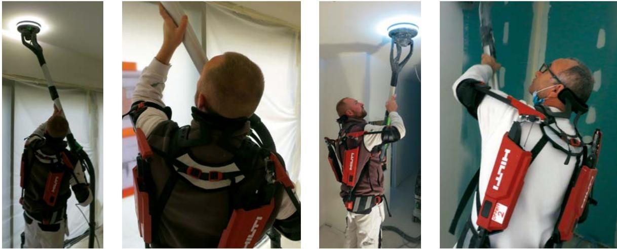
▲ Chantier 1 – Ponçage plafond et mur avec ponceuse de type girafe à dépression et exosquelette d'assistance « bras en hauteur » et soutien cervical
