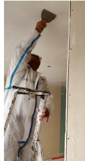
▲ Réparation ponctuelle d'enduit avec exosquelette d'assistance « bras en hauteur » et soutien cervical
