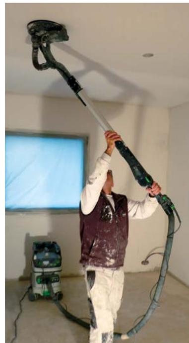
▲ Ponçage au plafond avec une ponceuse de type girafe
