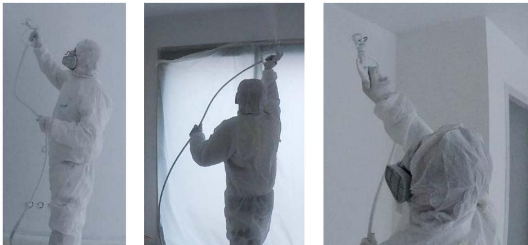
▲ Chantier 1 – Projection de peinture en plafond et mur, sans exosquelette
