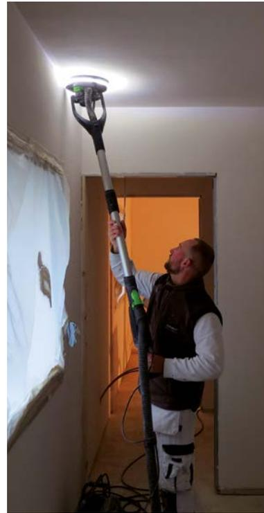
▲ Ponçage plafond avec ponceuse de type girafe à dépression et leds, sans exosquelette
