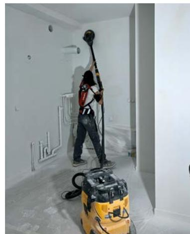
▲ Chantier 2 – Ponçage au mur avec exosquelette d'assistance aux travaux « bras en hauteur » et soutien cervical
