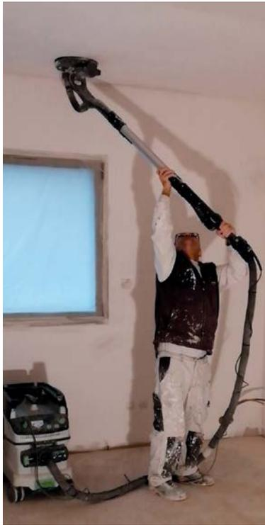
▲ Chantier 1 – Ponçage plafond avec ponceuse de type girafe à dépression, sans exosquelette
