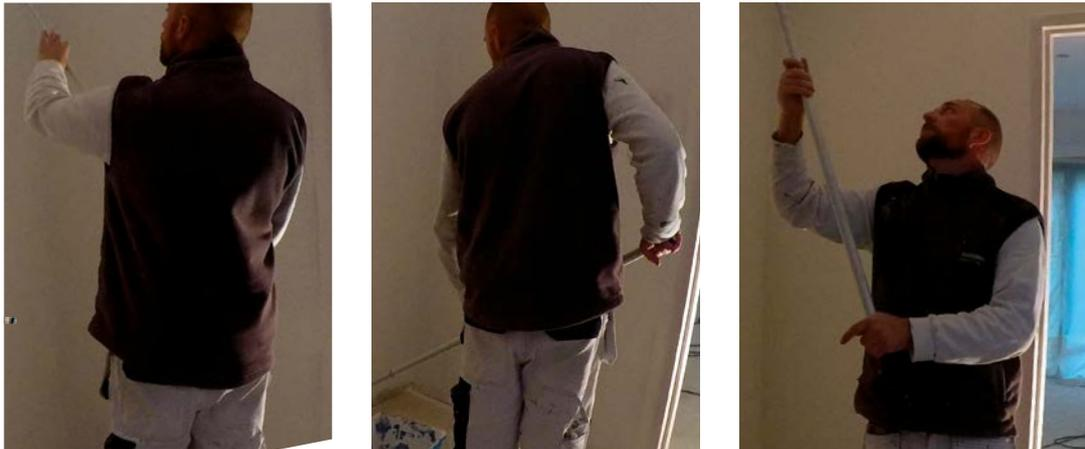
▲ Chantier 1 – Application de peinture au rouleau + perche, en plafond et mur, sans exosquelette
