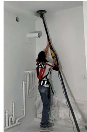
▲ Chantier 2 – Ponçage avec girafe (ponceuse a) et exosquelette d'assistance aux travaux « bras en hauteur », avec soutien cervical inclus
