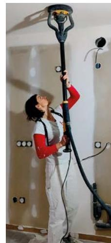
Chantier 2 – Ponçage avec girafe et exosquelette de soutien cervical dynamique ▶
