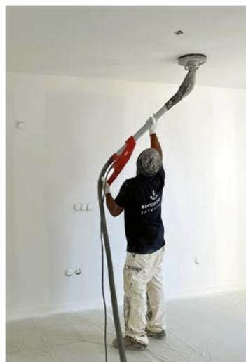
▲ Ponçage au plafond avec ponceuse de type girafe
