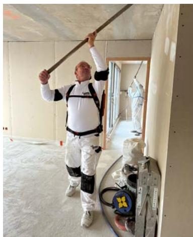
▲ Chantier 1 – Égrenage au plafond avec exosquelette d'assistance « bras en hauteur » et soutien cervical
