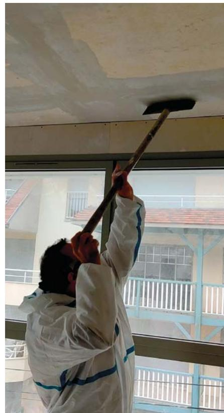
▲ Chantier 1 – Égrenage avec exosquelette
