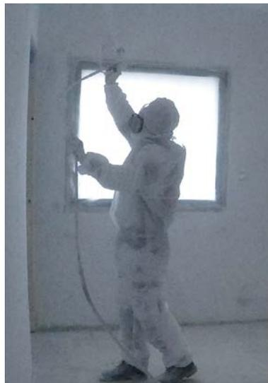
▲ Chantier 1 – Projection de peinture en plafond et mur, avec exosquelette d'assistance « bras en hauteur » et soutien cervical
