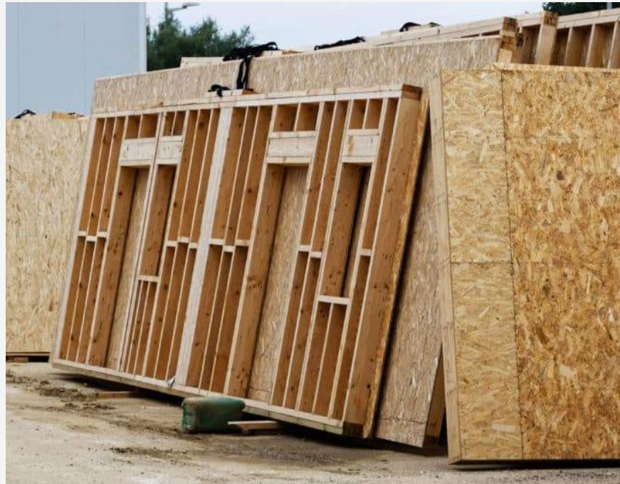
Mur ossature bois réalisé en usine
